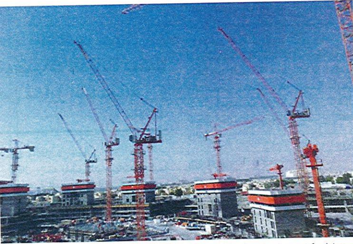
■ نشاط مكثف للرافعات البرجية في ظل مشاريع البناء | البيان
